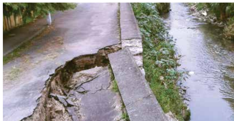
● Prefeitura não tem previsão para consertar asfalto da rua com erosão
